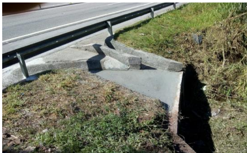
Figura 6.6 ViaLagos – Recuperação descida d'água – Km 19+900 Norte
