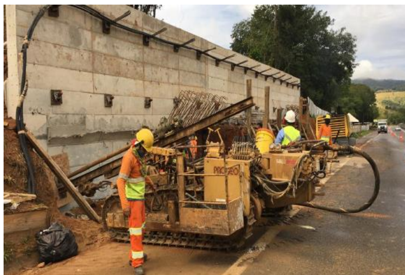
Figura 6.9 ViaLagos – Obra de recuperação de talude – Km 15+700 Sul
