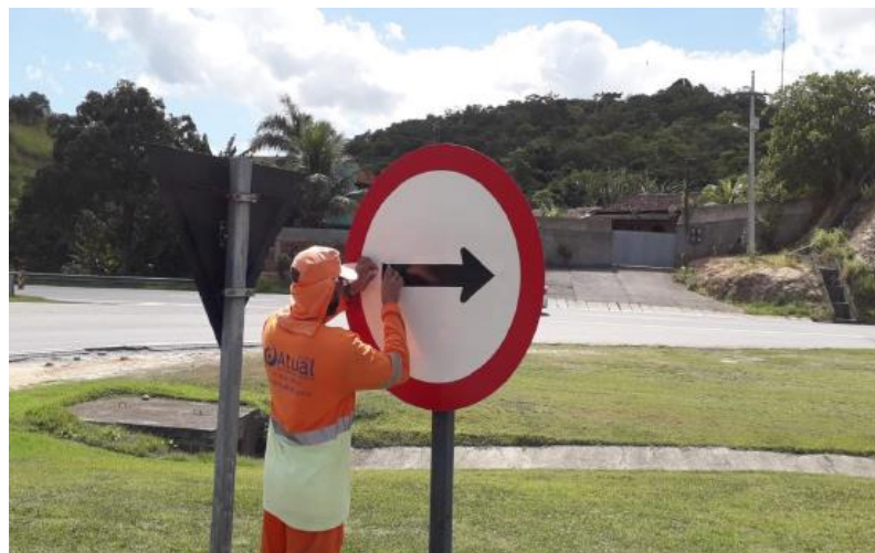
Figura 6.3 ViaLagos – Reparo de placa – Km 25+040 Norte
