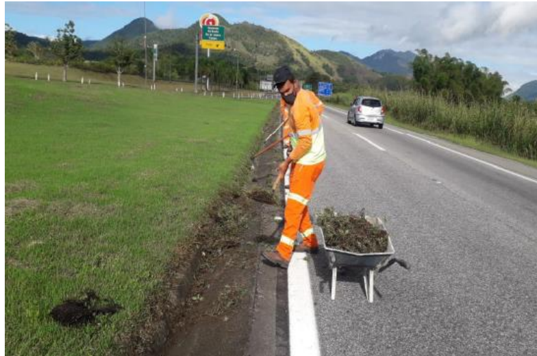
Figura 6.5 ViaLagos – Limpeza da sarjeta – Km 23+000 Sul
