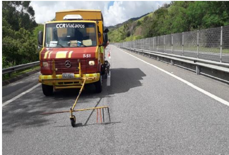
Figura 6.2 ViaLagos – Pintura de faixas – Km 15+000 Sul
