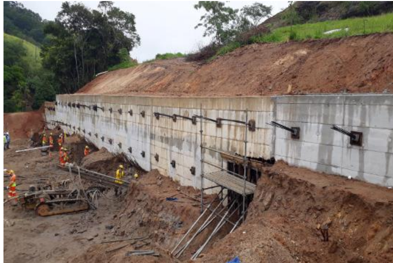
Figura 6.8 ViaLagos – Obra de recuperação de talude – Km 15+700 Sul
