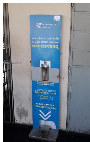
Figura 5.15 SuperVia – Estação Penha– 06/04/2021
